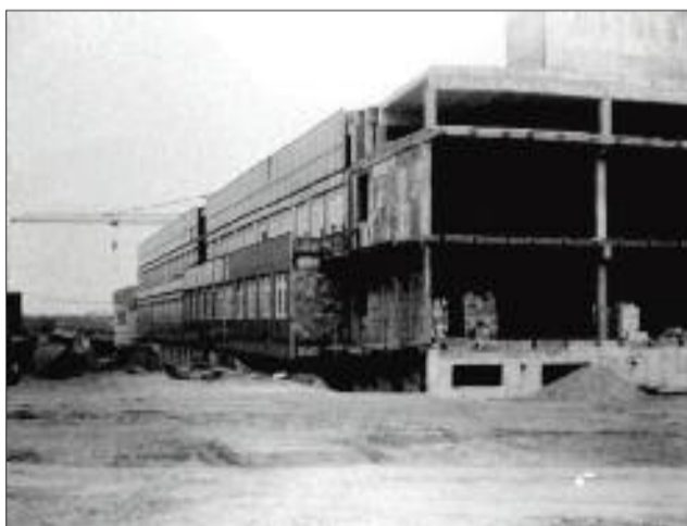
Prawie gotowy szpitalny blok i zaledwie konstrukcja następnego. W przeliczeniu na dzisiejsze pieniądze budowa szpitala kosztowała 600 mln zł!
