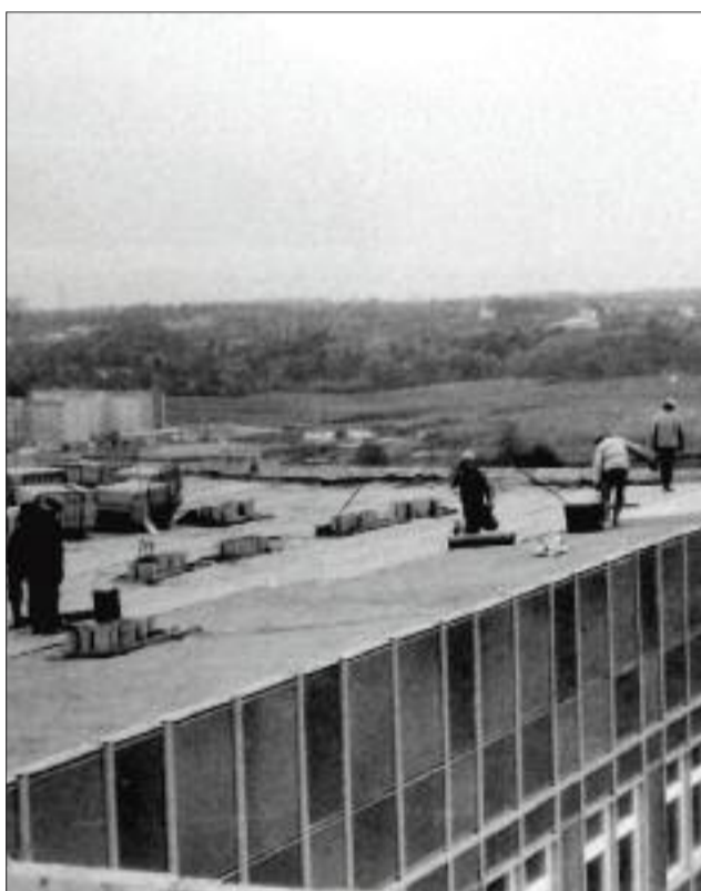
Jedno z nielicznych zdjęć, na którym widać budowniczych szpitala. Dziś trudno sobie wyobrazić, że można było wykonać takie fotografie bez użycia drona
