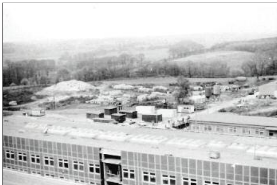
Szpital w budowie. W oddali charakterystyczne baraki i... pola. Co ciekawe, obiekt postawiony na potrzeby budowlanców (nie ma go na zdjęciu), to dziś m.in. dział administracji wraz z archiwum
