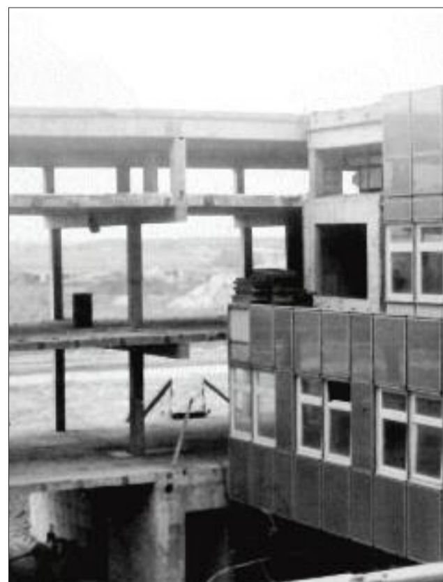
Szpital był budowany w nowatorskiej wówczas technologii monolityczno - ślizgowej, czyli z żelbetu za pomocą ruchomych szalunków nazywanych ślizgami
