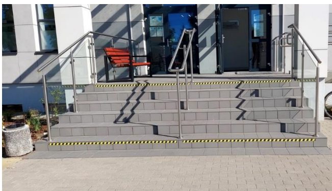
Zdjęcie nr 3: schody zewnętrzne
