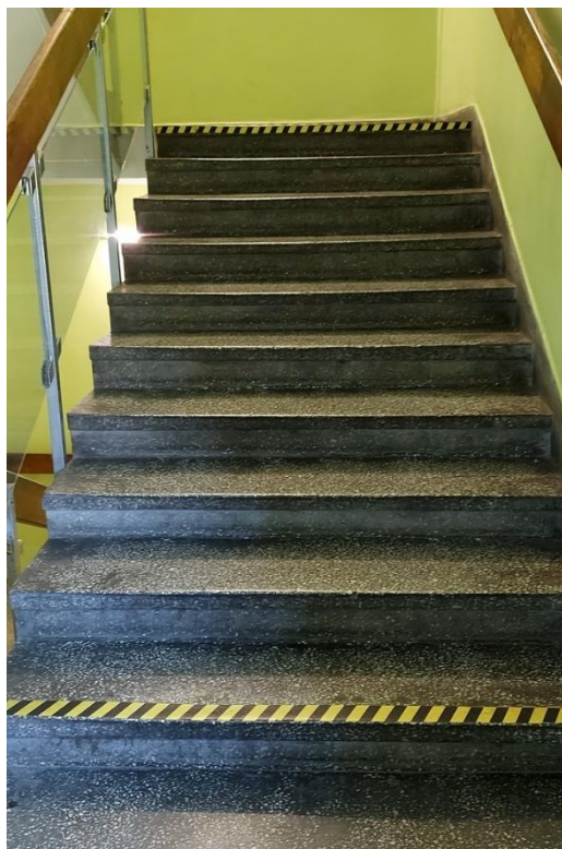
Zdjęcie nr 10: Schody wewnętrzne
