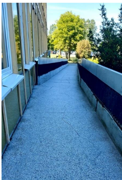
Zdjęcie nr 4: pochylnia do głównego budynku
