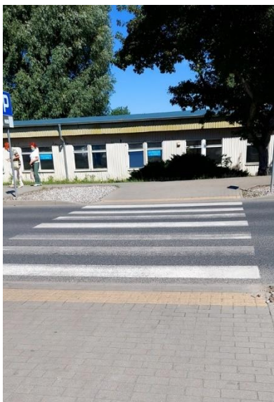
Zdjęcie nr 2: Budynek rejestracji tymczasowej
